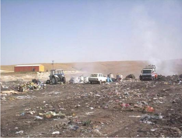
Çöplükten dezenfekte binasının görünümü
