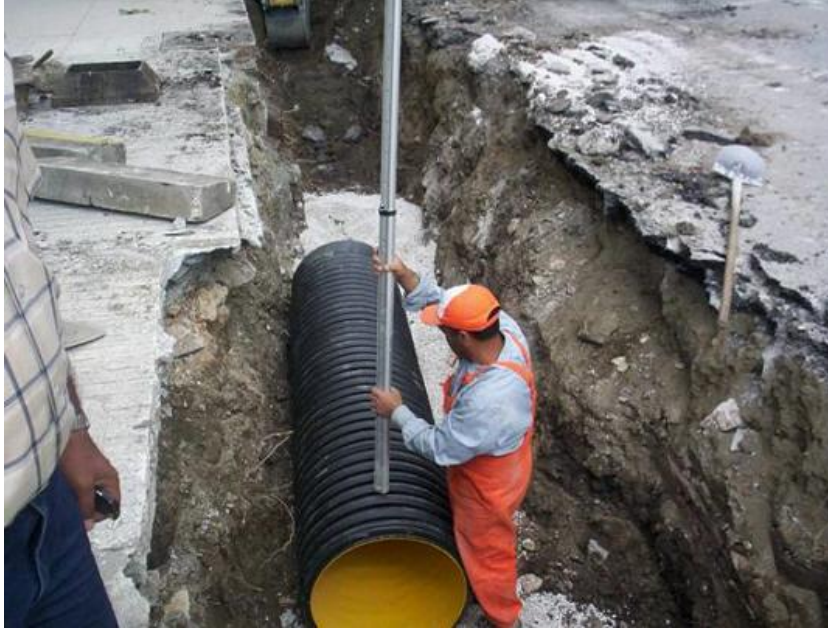
PTT ÖNÜ AÇILAN BORU DÖŞEME HATTI KOT ÖLÇÜMÜ
