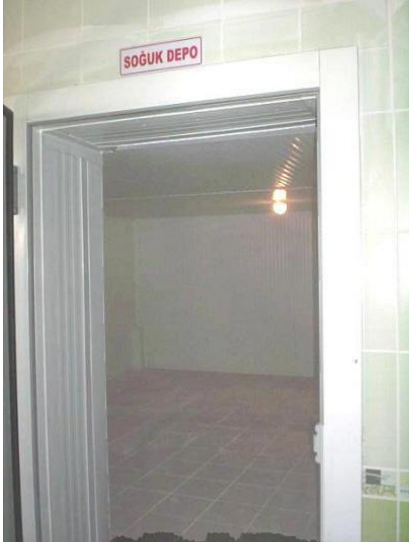
Tıbbi atık saklama soğuk hava deposu
