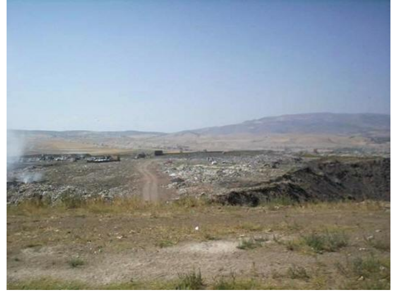
Dezenfekte binasından Çöplük alanını genel
