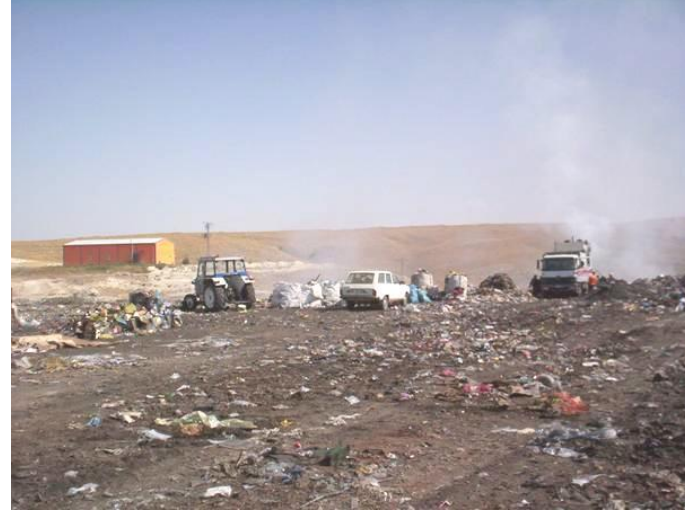
Resim 21 Çöplükten dezenfekte binasının görünümü
