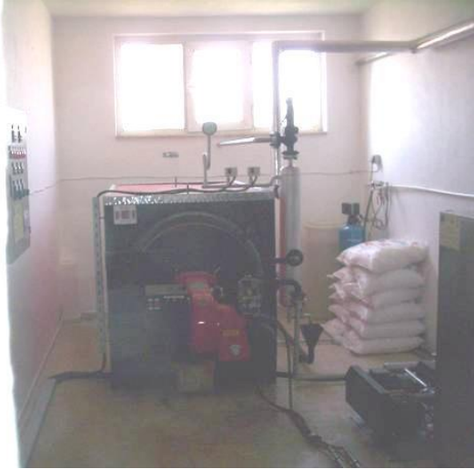
Tıbbi atık dezenfekte edilirken kullanılan buhar üreticisi
