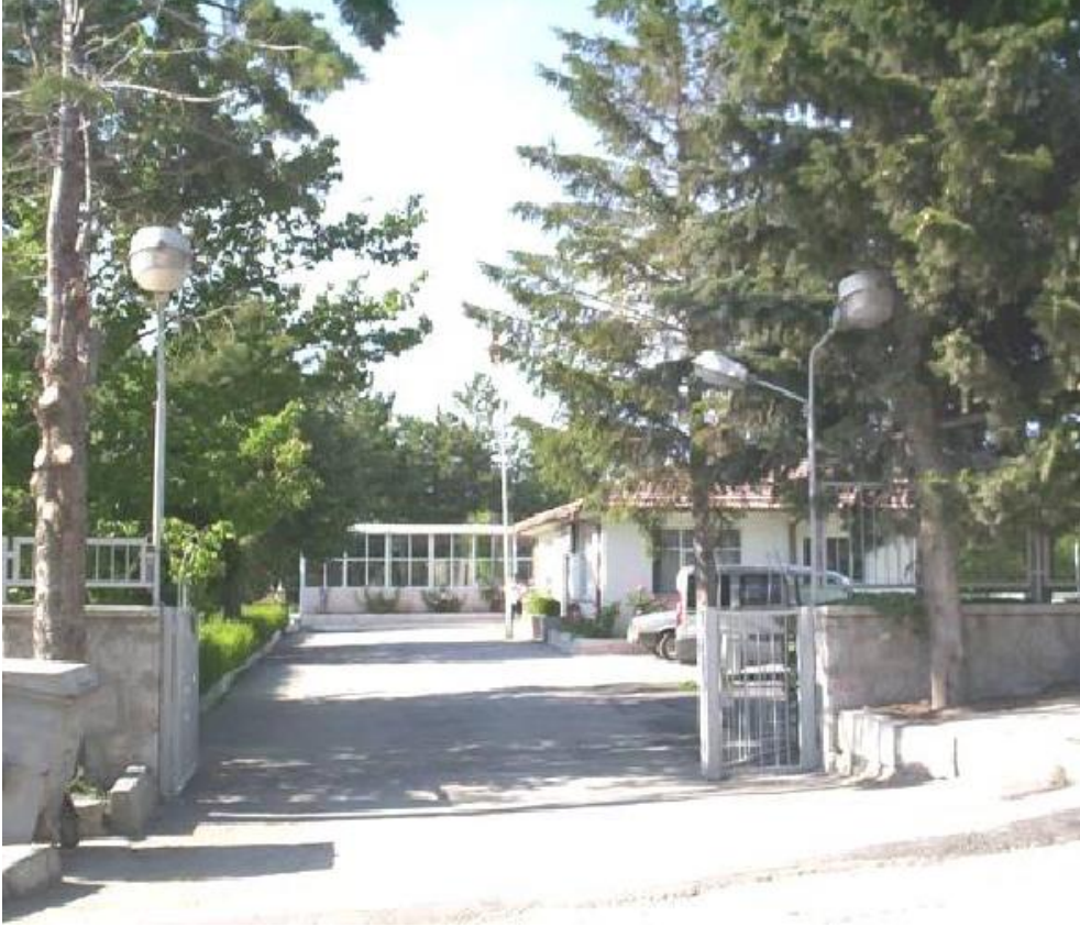
Bahabey Su Arıtma Girişi
